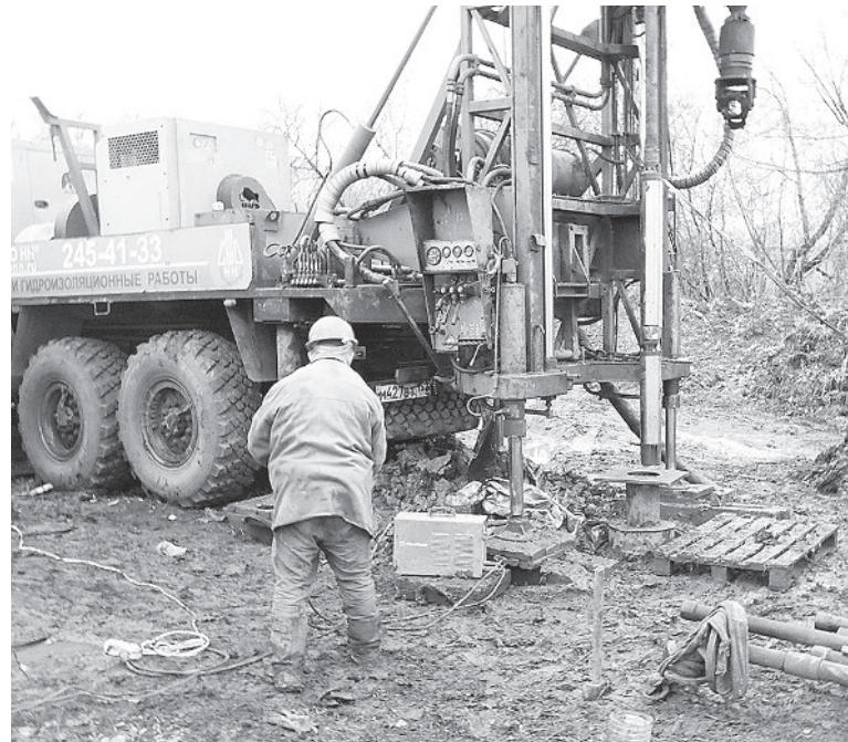
Бурение артезианской скважины осенью текущего года
